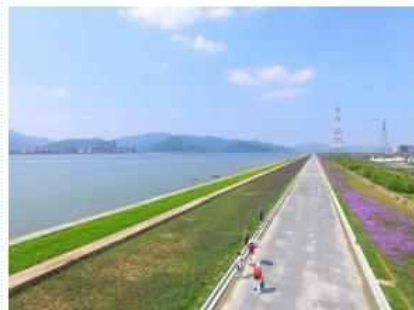
环梅山湾海堤改造提升工程
