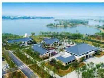
武汉环东湖绿道景观工程施工
